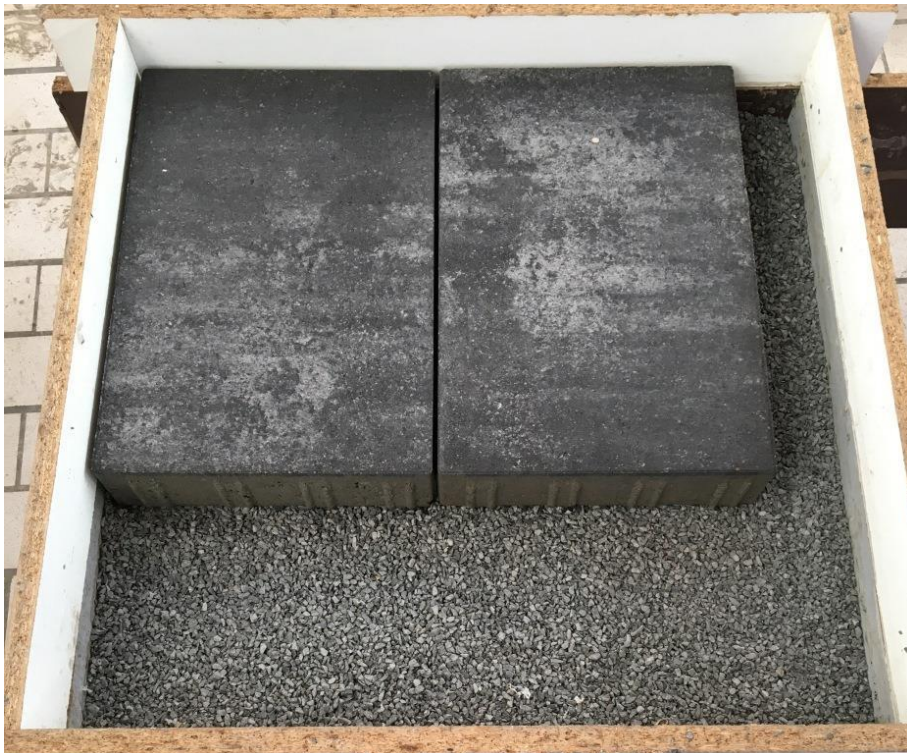
Abbildung 1: Verlegung im Hartsteinsplitt 2/5 mm
