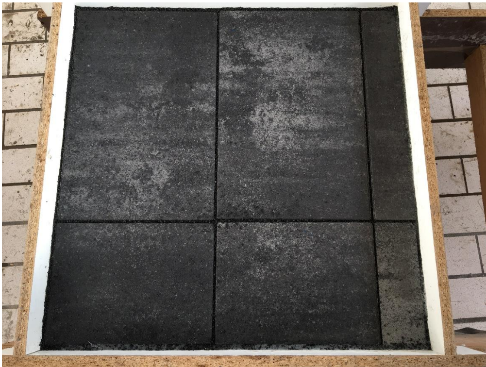
Abbildung 3: Prüffläche mit Fugenverfüllung
